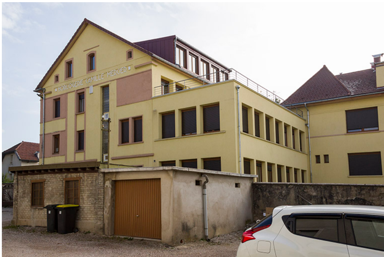
Immeuble et extension, depuis le sud-ouest.
