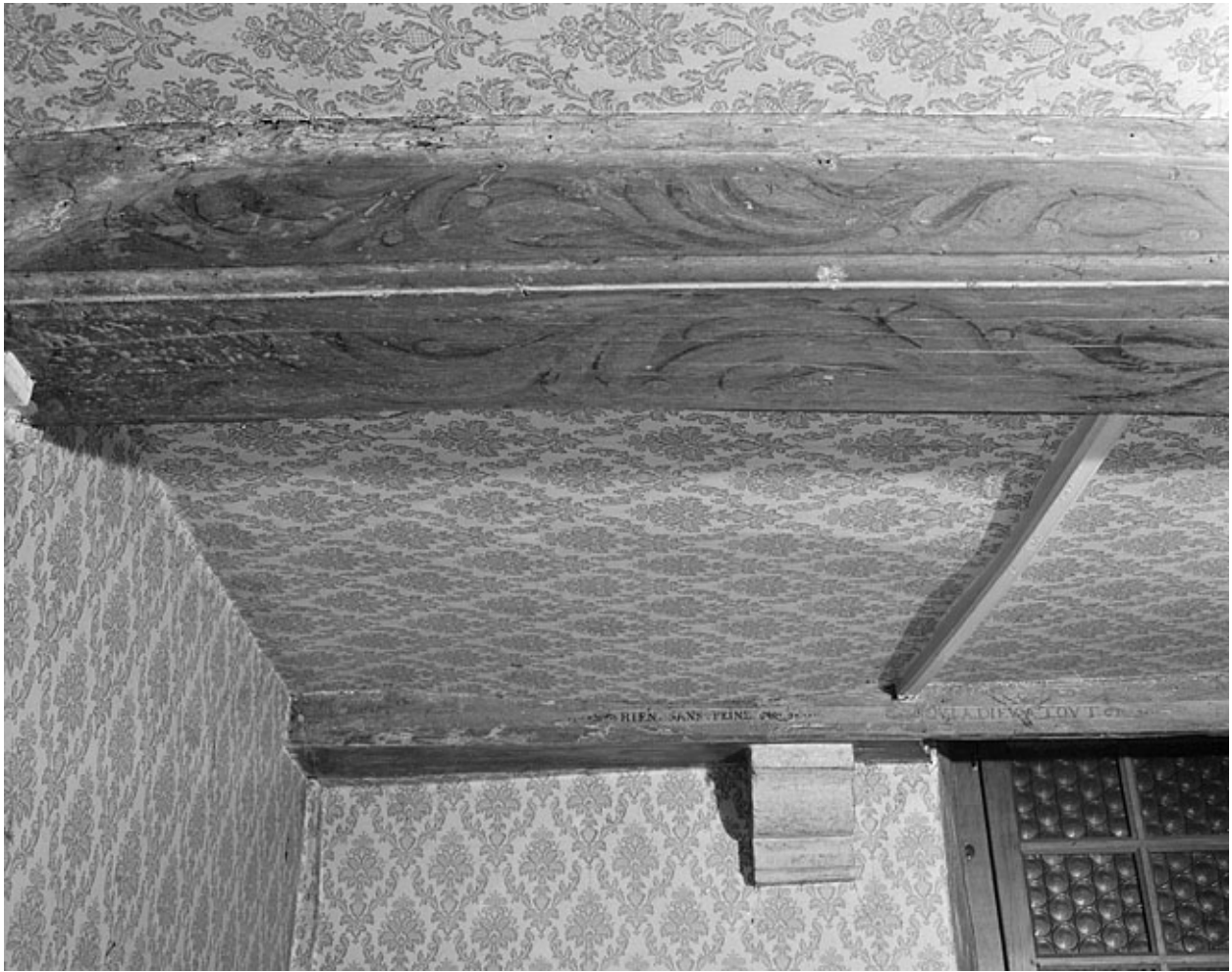
Premier corps de bâtiment. Plafond du rez-de-chaussée.
