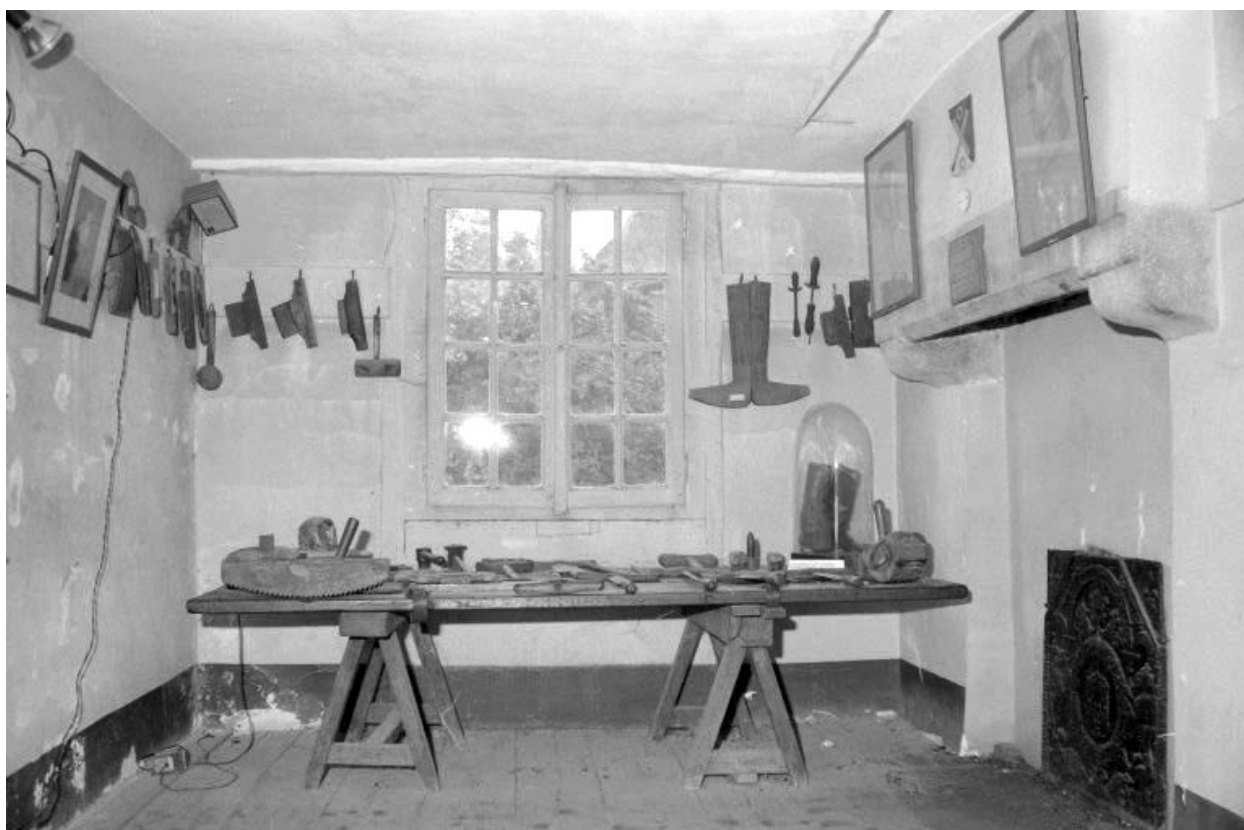
Rez-de-chaussée : intérieur de l'atelier de corroierie.
