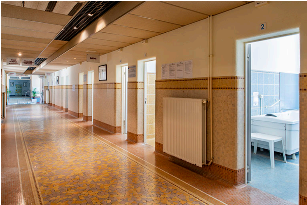
Bâtiment d'Hygie, couloir central du rez-de-chaussée, vue en direction du sud.
