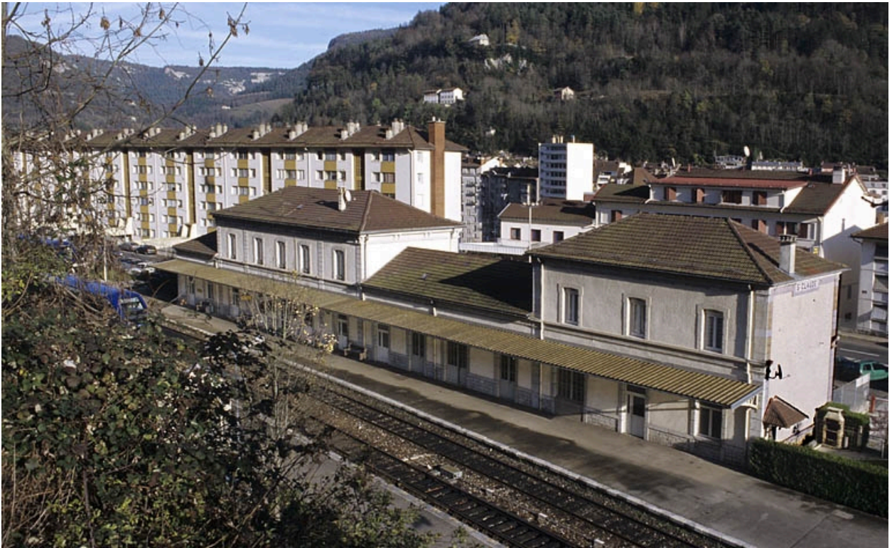
Bâtiment des voyageurs : vue plongeante sur la façade postérieure, de trois quarts droite.
