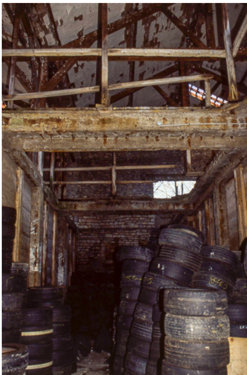
Intérieur d'un magasin industriel.
