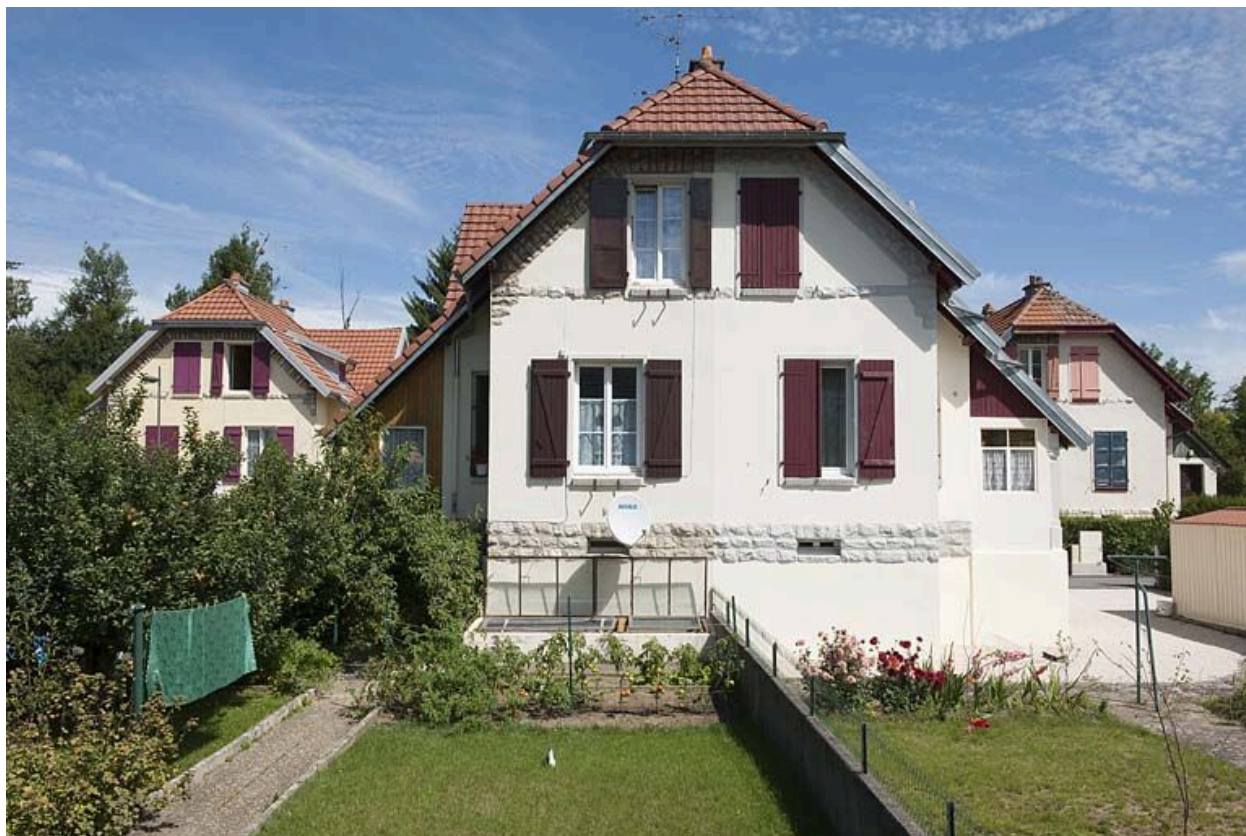
Pignons de maisons vus de face.
