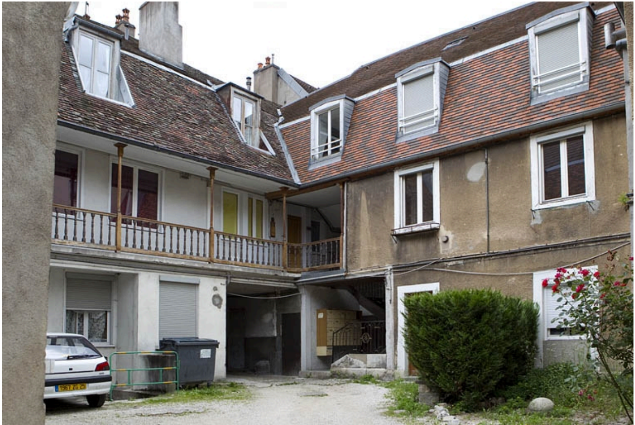
Vue des façades sur cour du logis principal, de trois quarts gauche.
