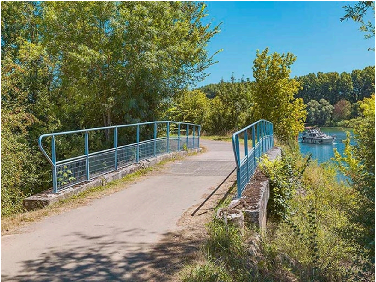
Vue d'ensemble du pont, d'aval.
