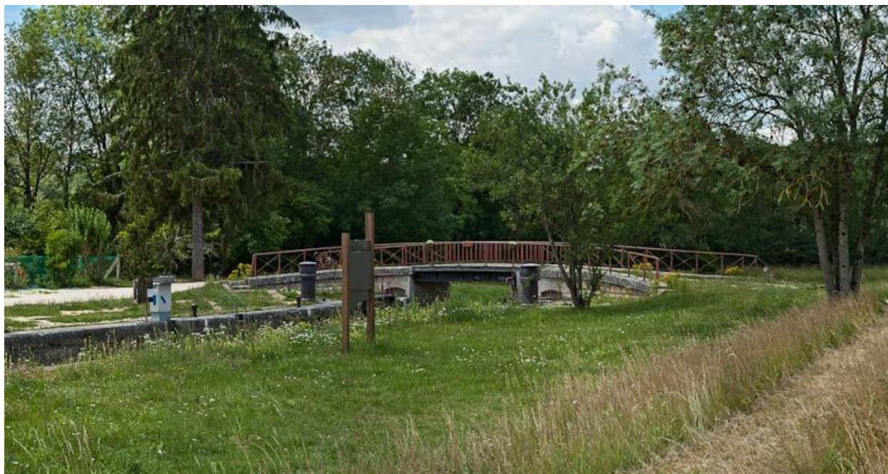
Vue du pont depuis l'amont.
