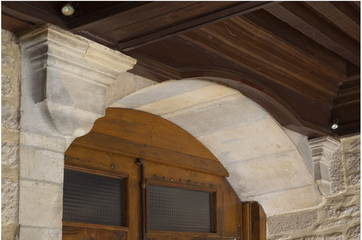
Logis principal, portique : détail de la partie supérieure d'une baie.
