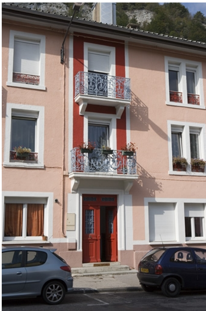
Façade antérieure : travée de la porte d'entrée.
