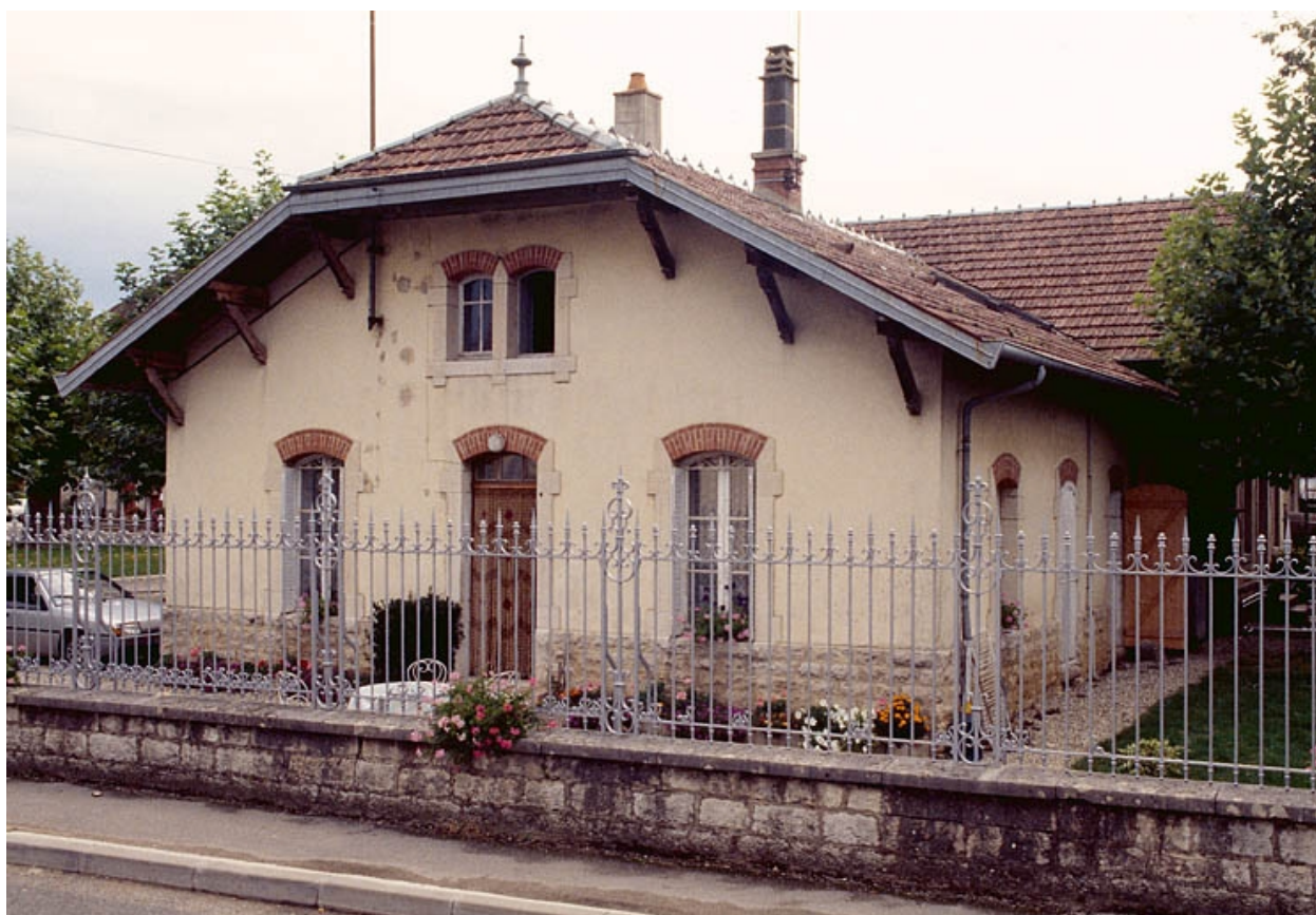
Mur-pignon et façade postérieure depuis l'ouest.
