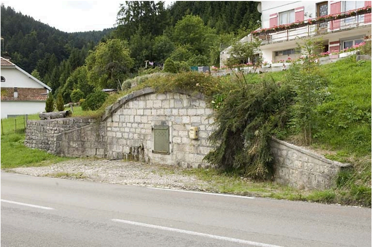
Réservoir des Tavins (route de Vallorbe, 2008 AH 16).
