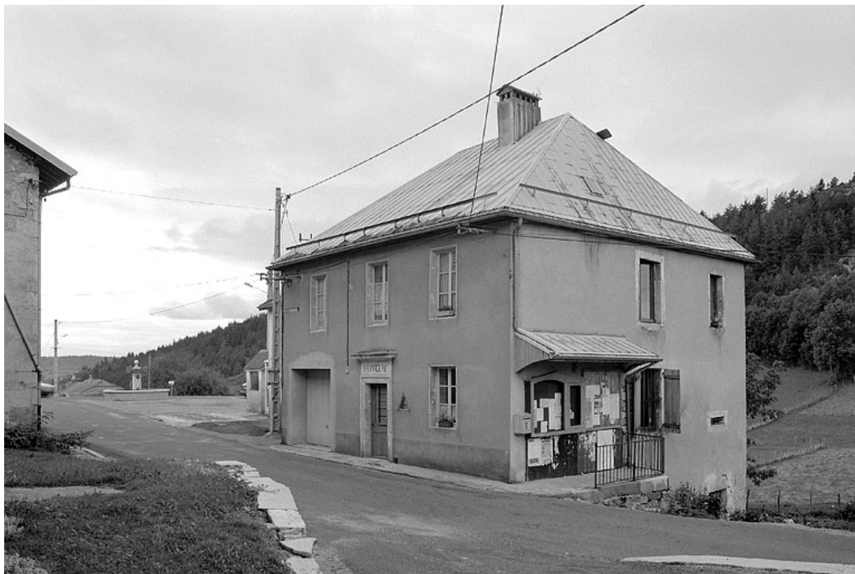
Façade antérieure et face latérale droite.
