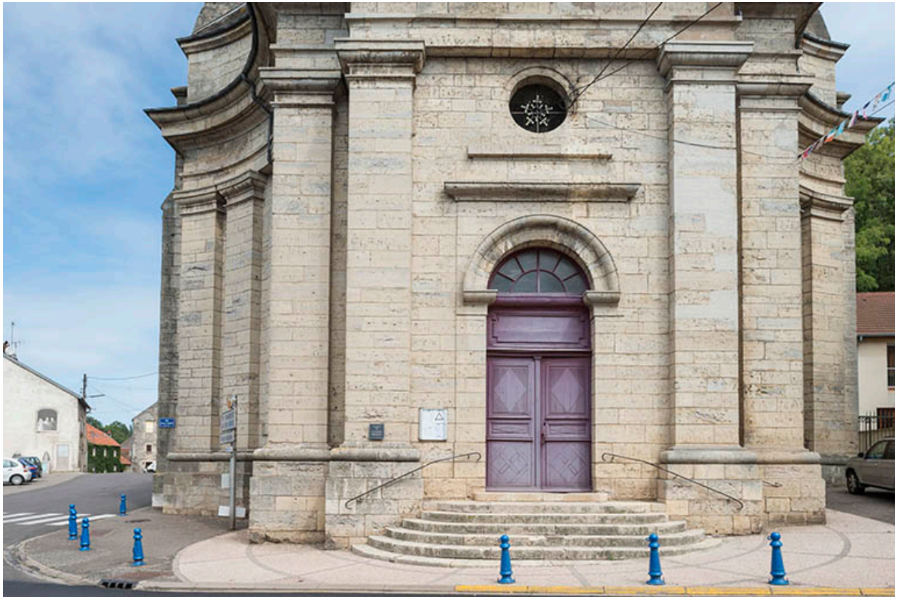
Le portail de l'église paroissiale.
