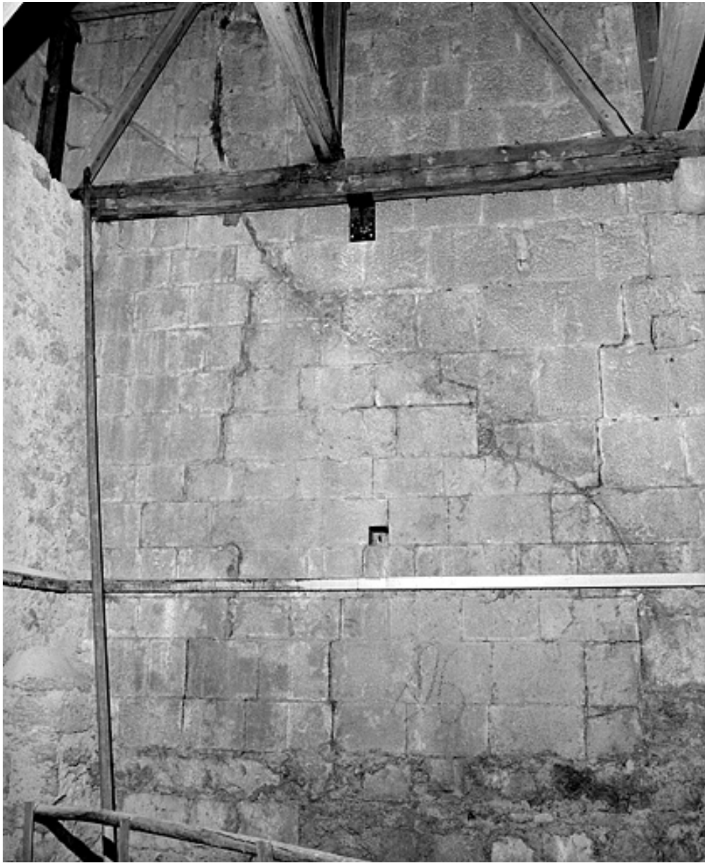
Revers de l'aileron nord de la façade.
