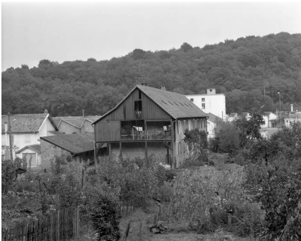
Vue d'ensemble depuis l'ouest en 1981.
