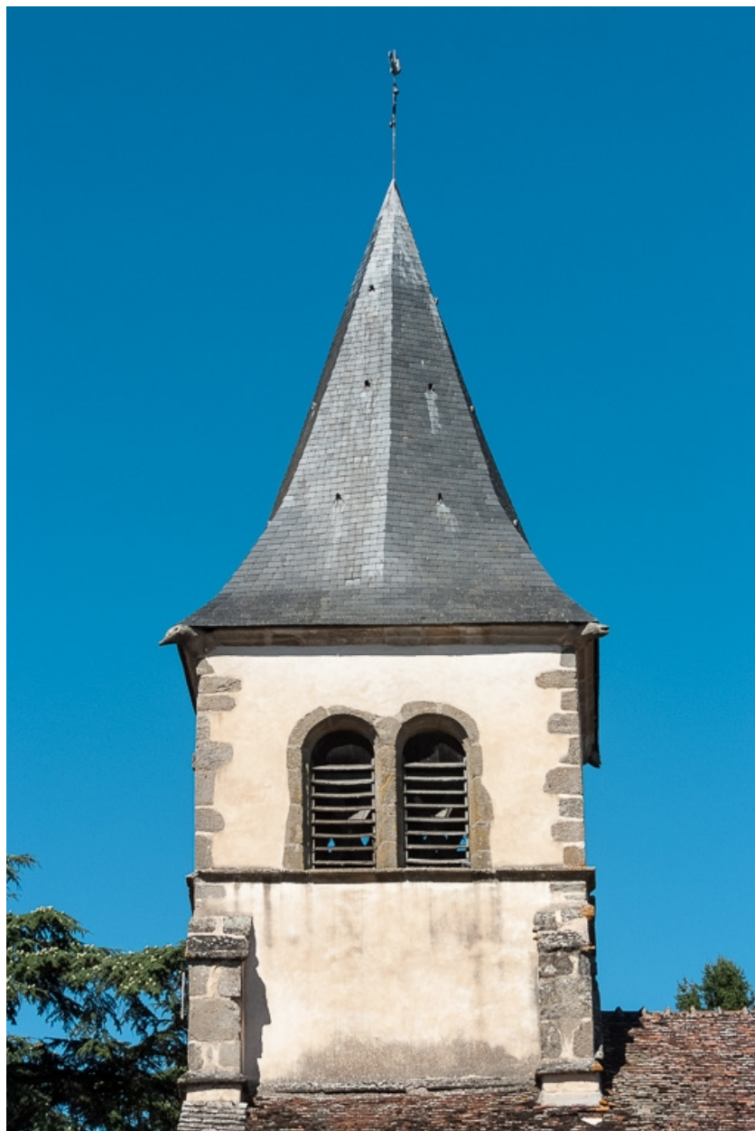
Elévation sud du clocher.
