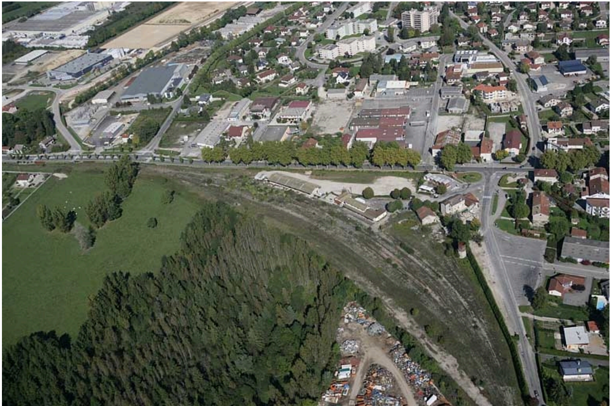
Vue aérienne du site de la gare, depuis le sud-est.
