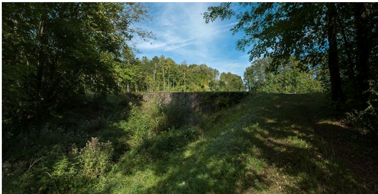
L'aqueduc du milieu du bief dans la végétation.
