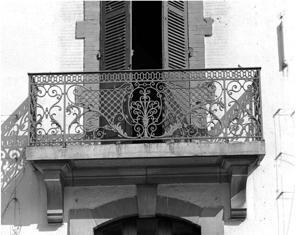
Grille d'un balcon des bureaux (extrémité occidentale).
