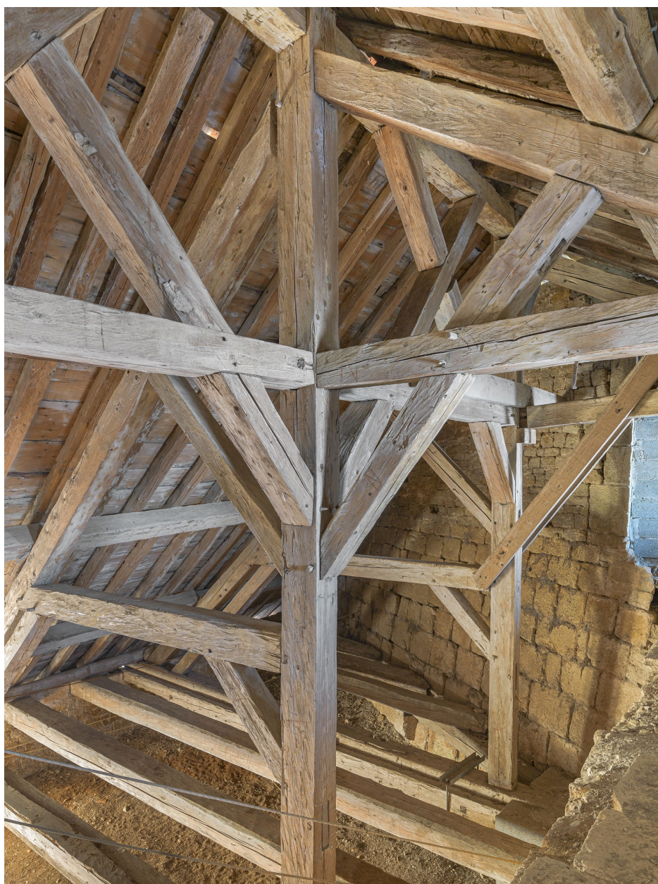
Pavillon d'entrée : détail de la charpente.
