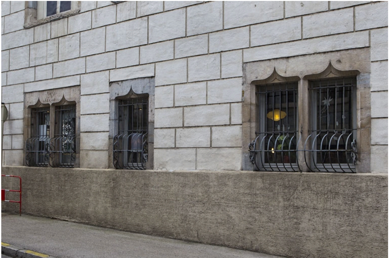
Façade latérale droite, détail du rez-de-chaussée.
