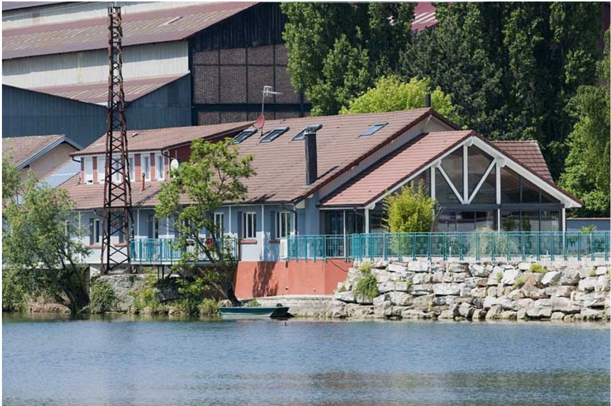
Magasins industriels (réhabilités) depuis le sud-est.
