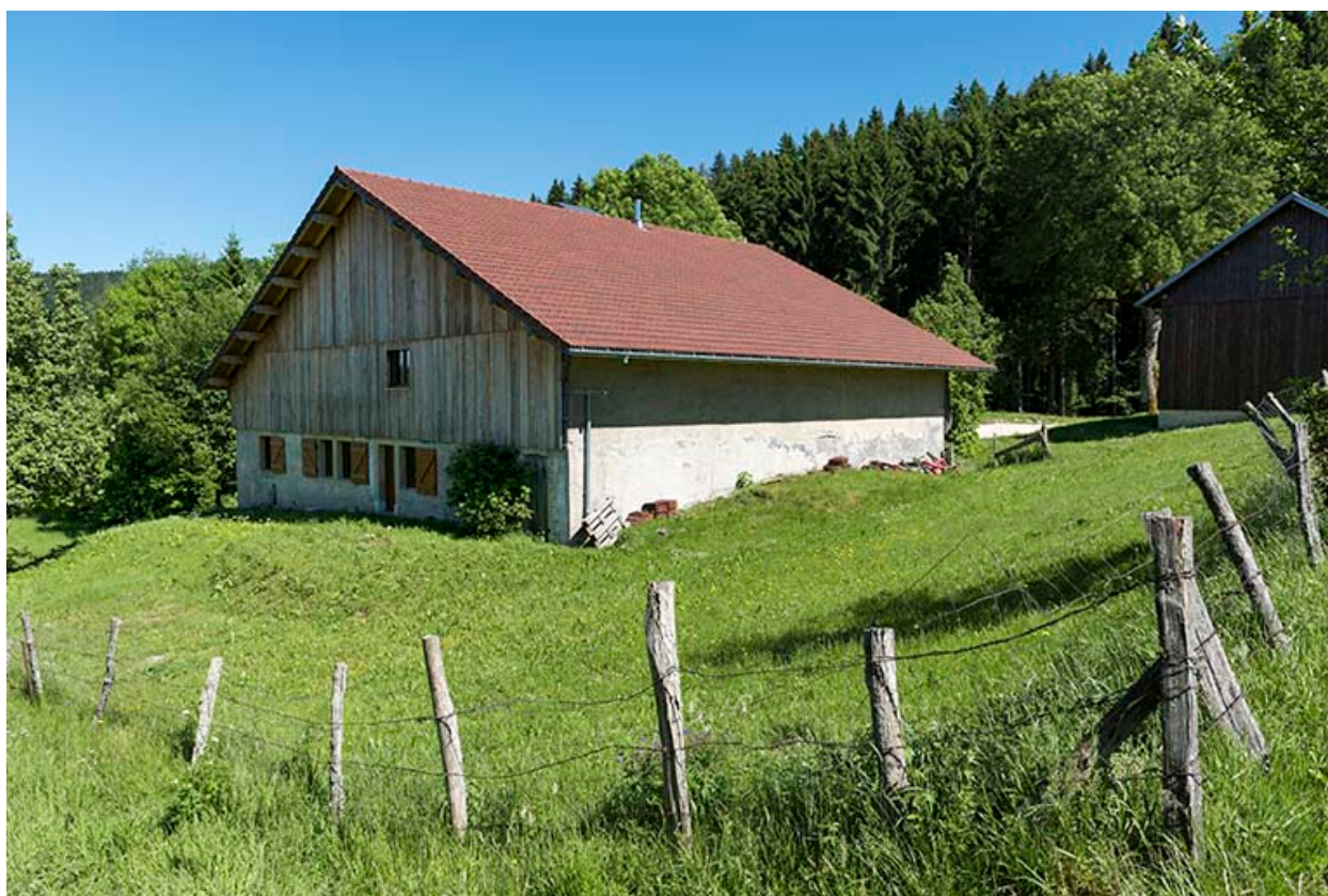
Façades postérieure et latérale gauche.
