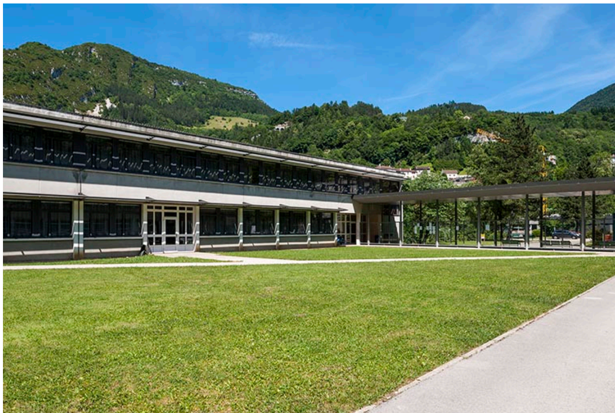
Externat tertiaire : façade antérieure.
