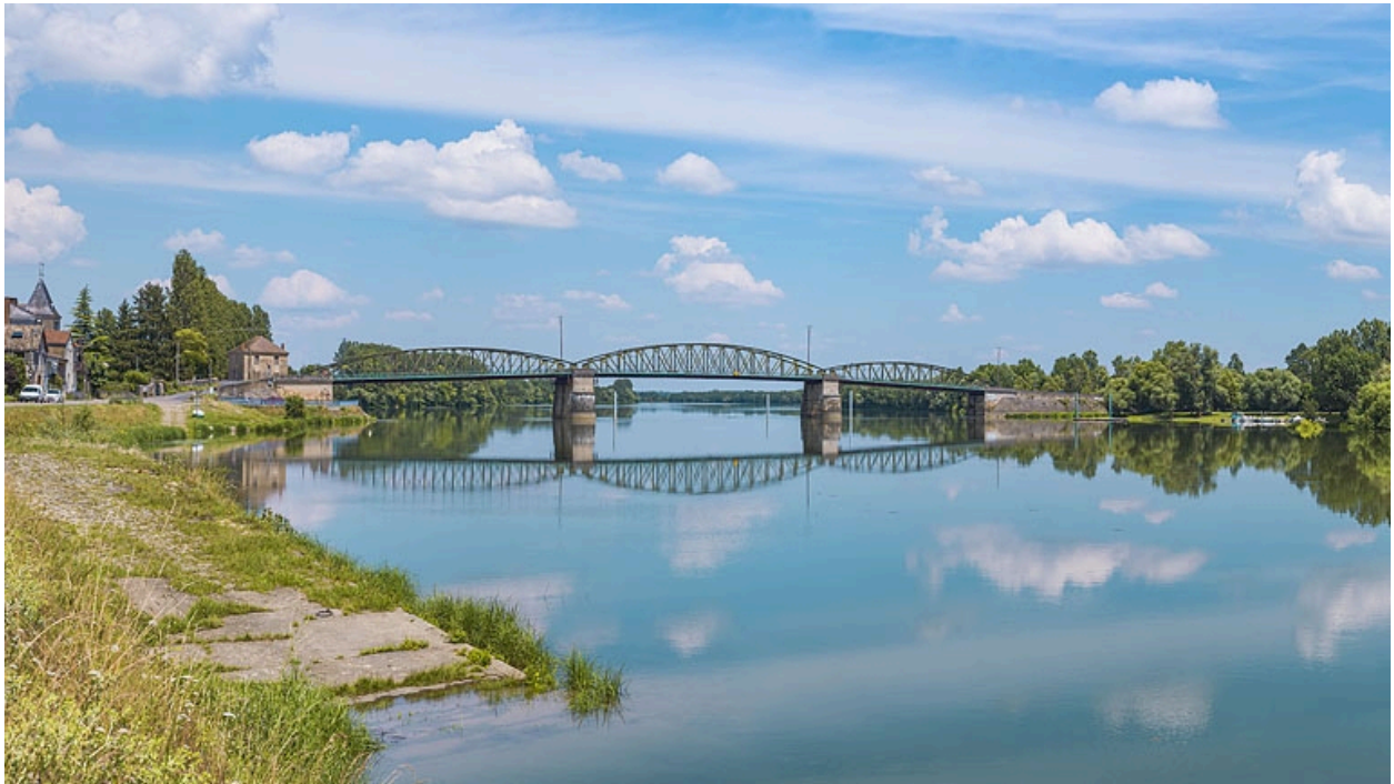
Le pont de Fleurville, vu d'aval, depuis la rive droite.
