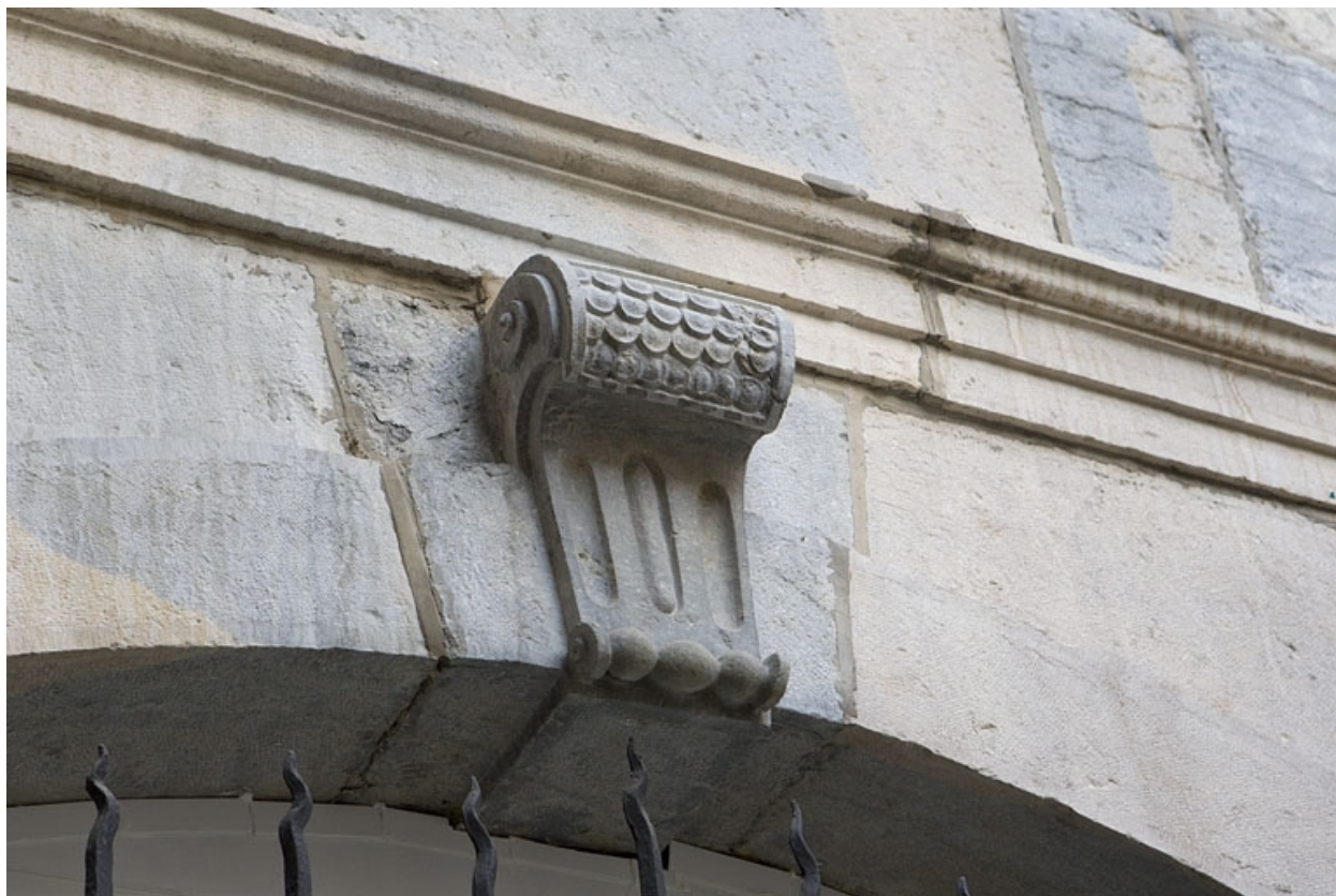
Façade antérieure en fond de cour : détail d'une clé de fenêtre.
