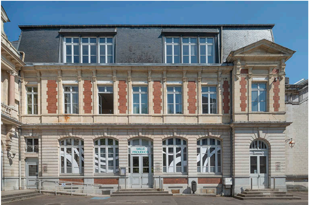
Ancienne brasserie (bâtiment Proudhon) : façade antérieure.
