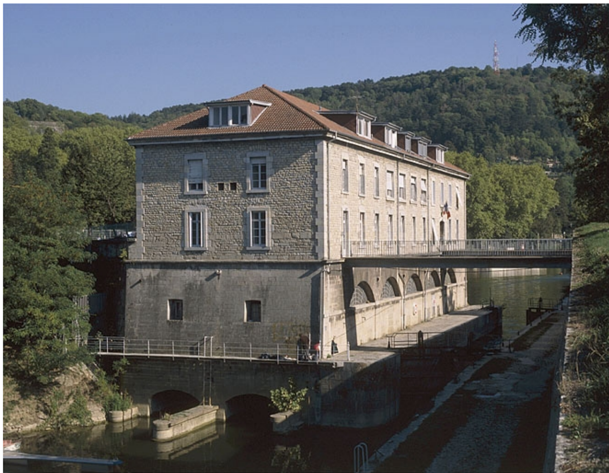
Le moulin de trois quarts gauche (aval).
