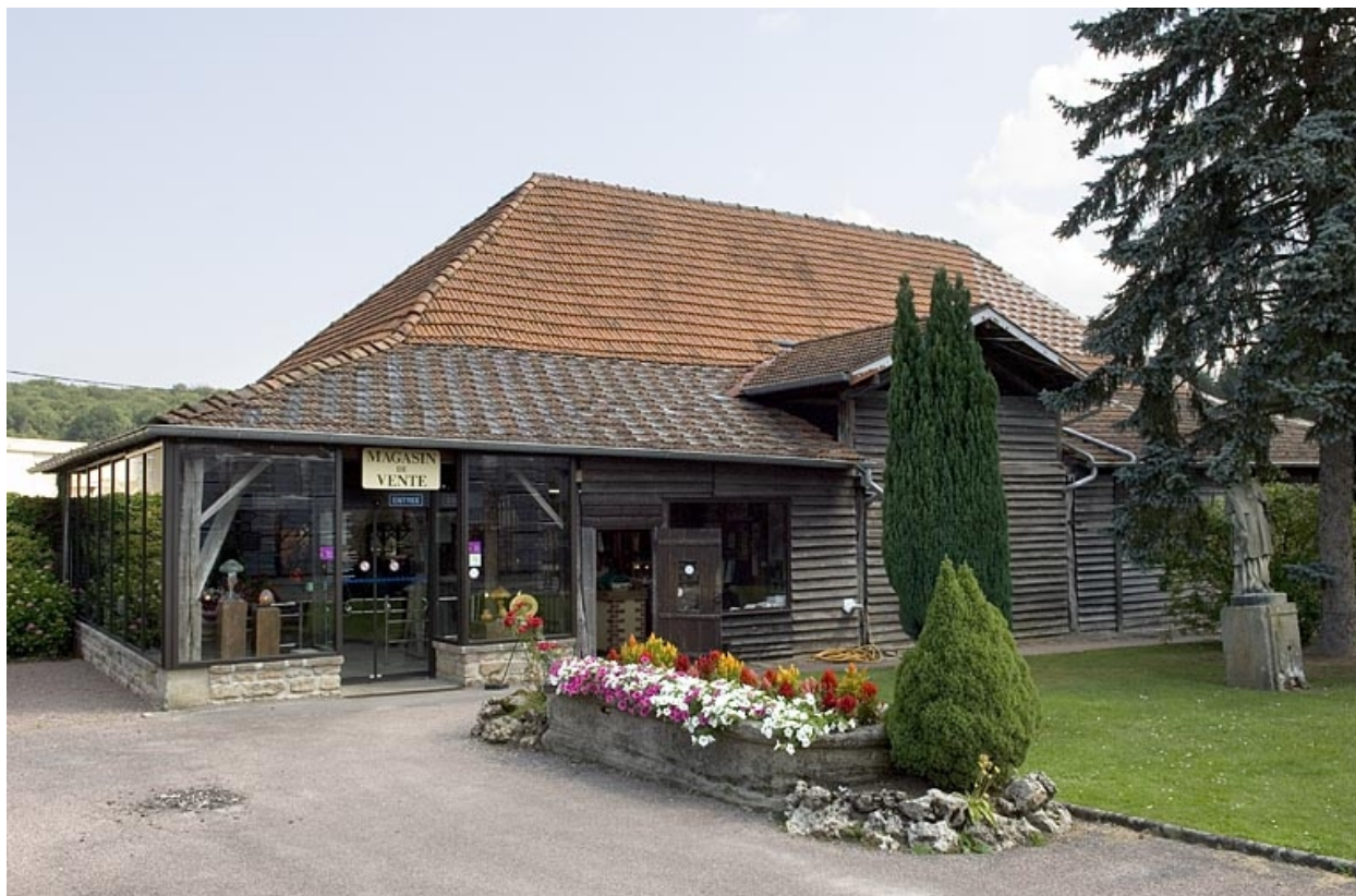
Ancien séchoir à bois (boutique).
