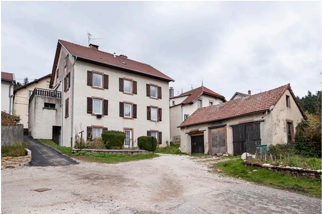
Façade postérieure et ancien atelier ou remise.
