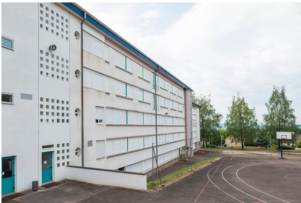
Externat : ensemble des façades arrière.
