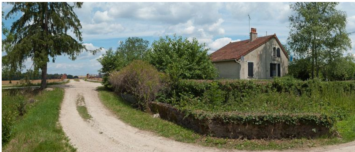
Vue de l'arrière de la maison éclusière.
