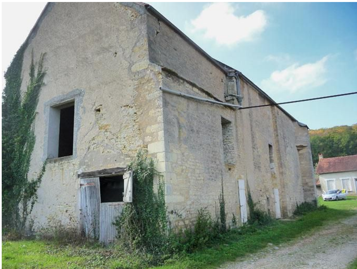
Murs postérieur et gauche de la chapelle.
