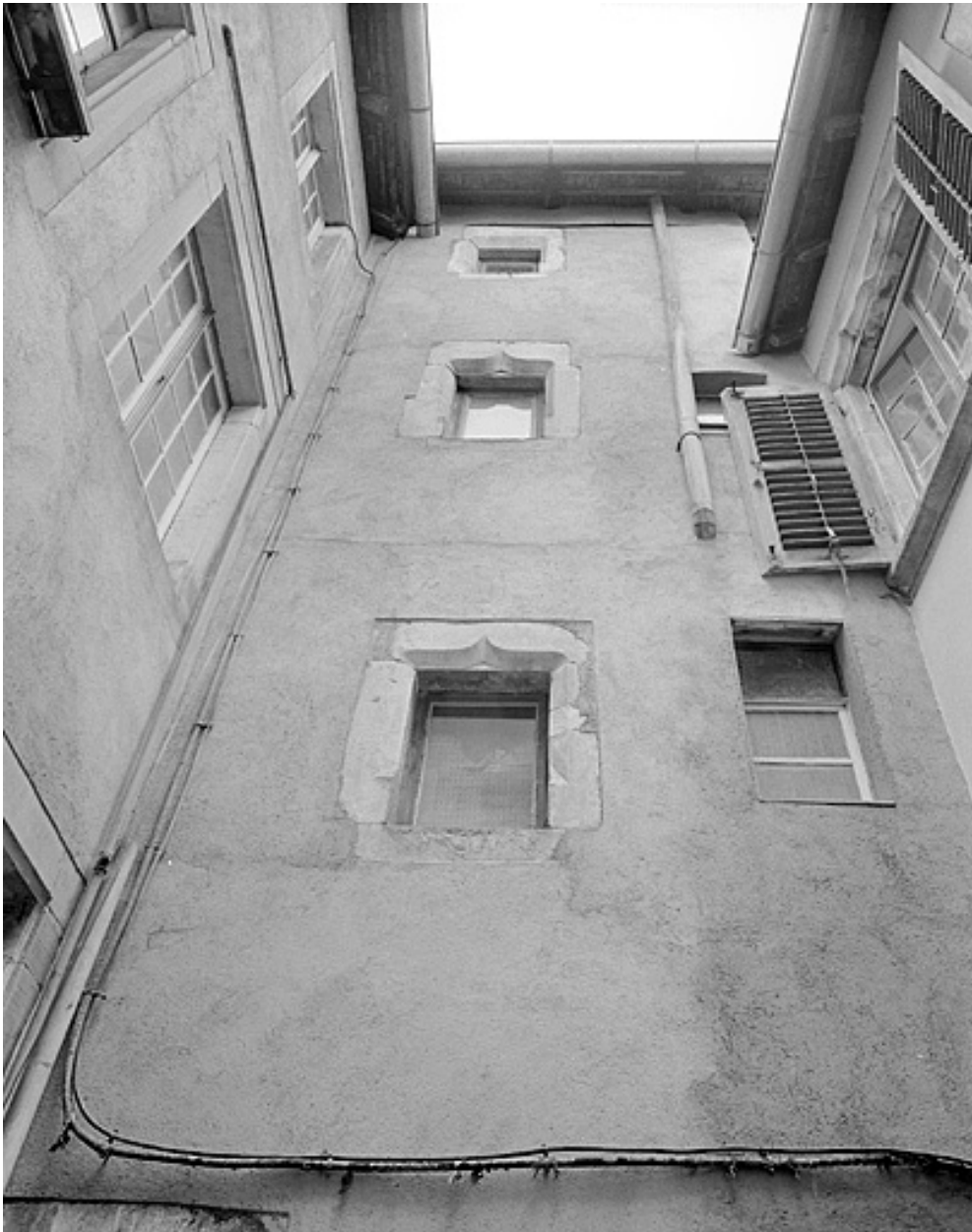
Maison 27, rue des Febvres. Tour d'escalier. Première moitié 16e siècle.
