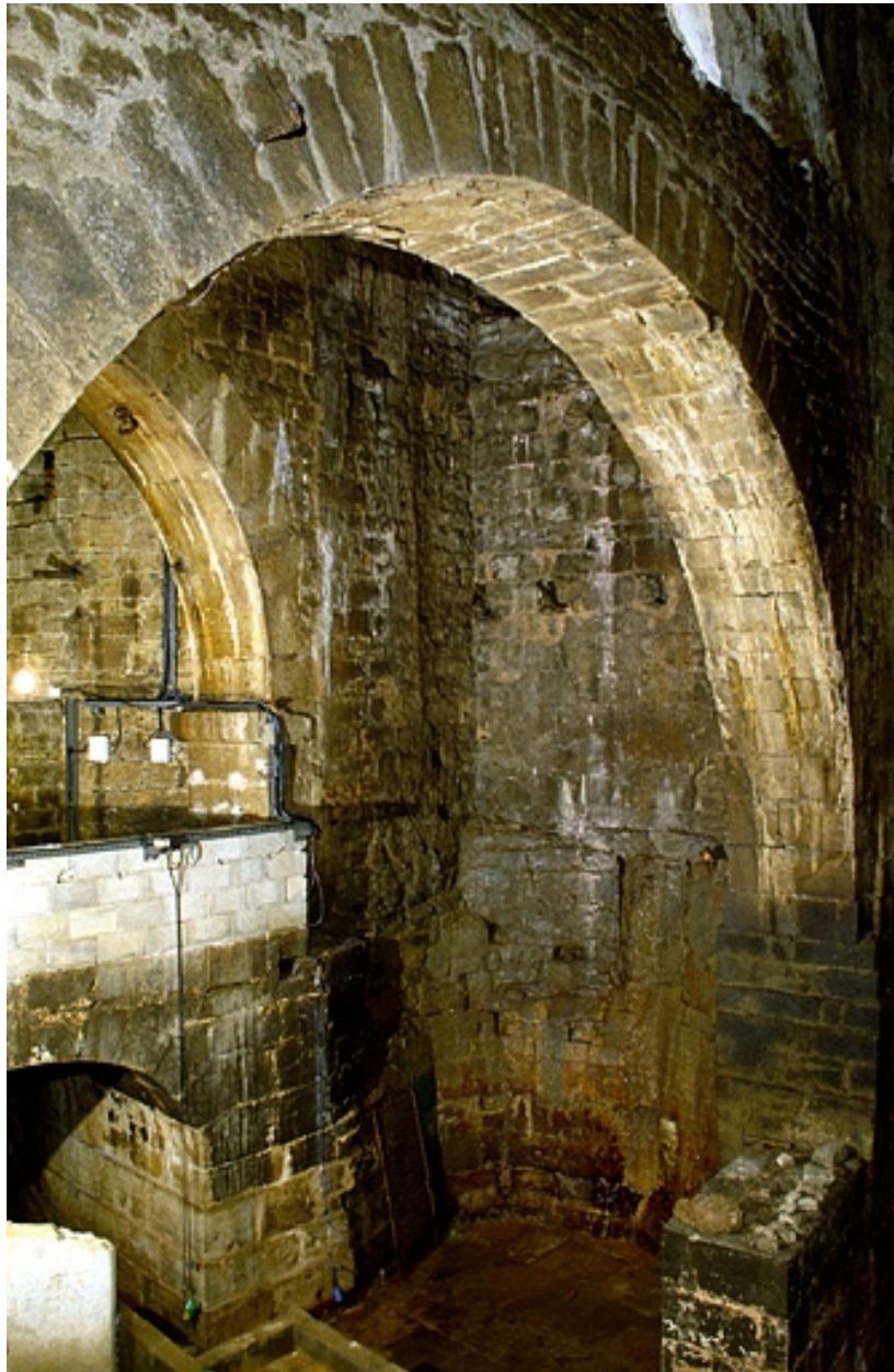
Vue plongeante sur le fond du puits.
