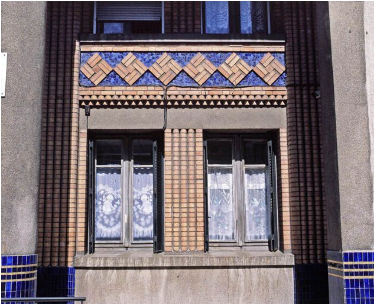
Bâtiment A : appareil de briques et mosaïques de la conciergerie.
