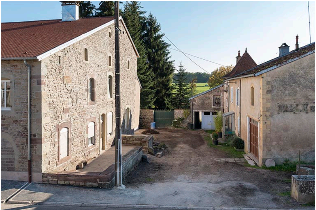
Vue du mur pignon ouest.
