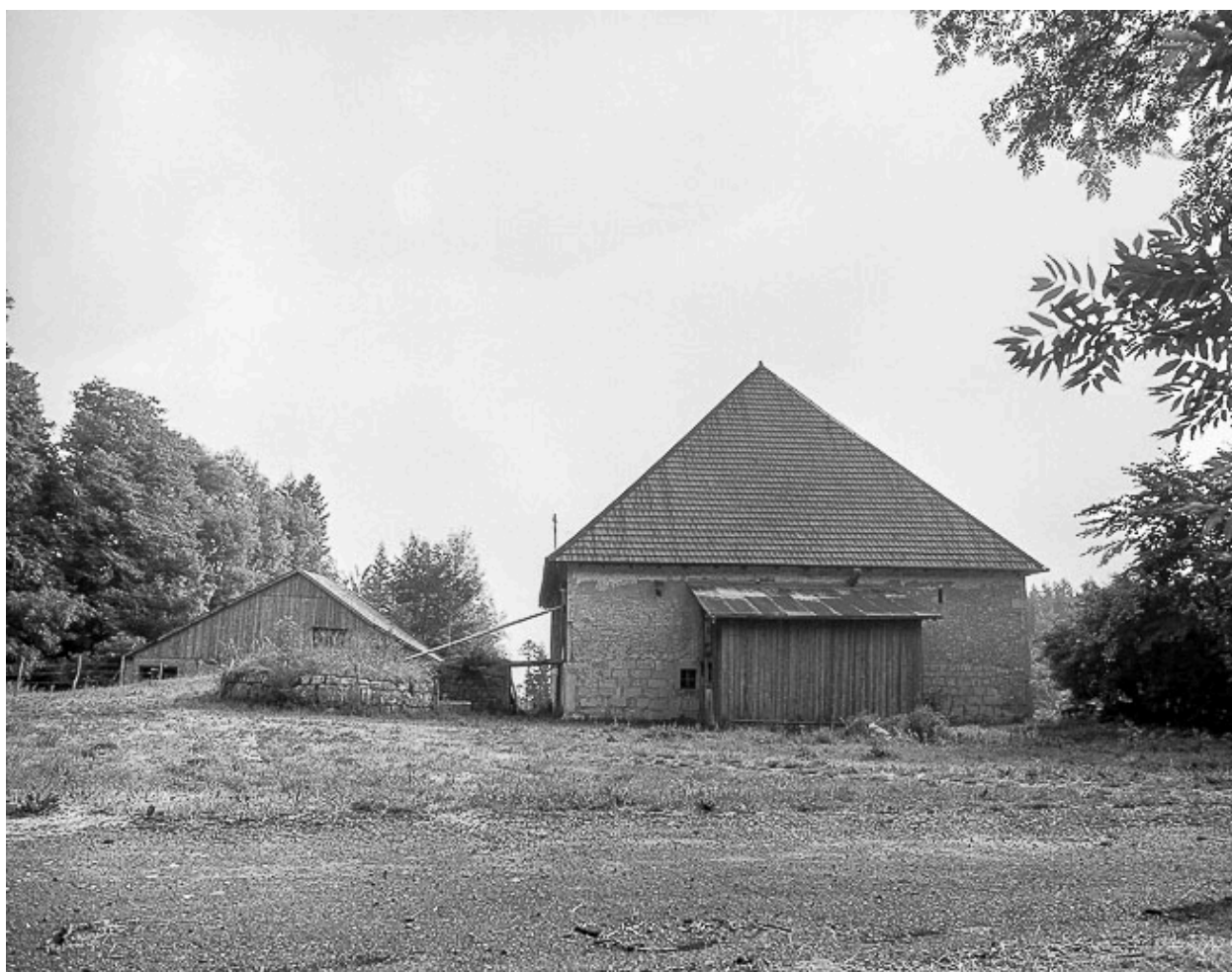
Ferme située au lieu-dit Champagne-Dessus, cadastrée ZL 1 : façade postérieure.
