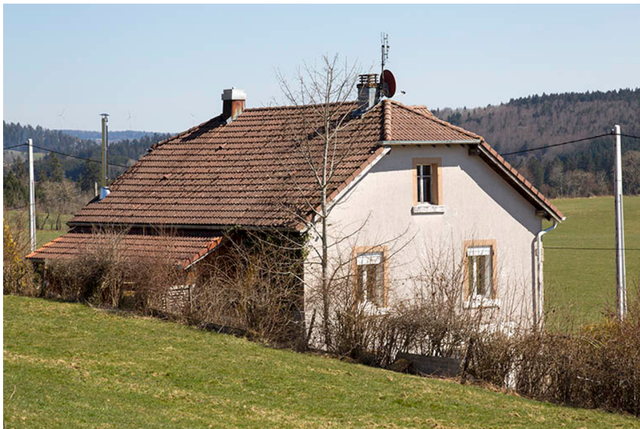
Façades postérieure et latérale droite.
