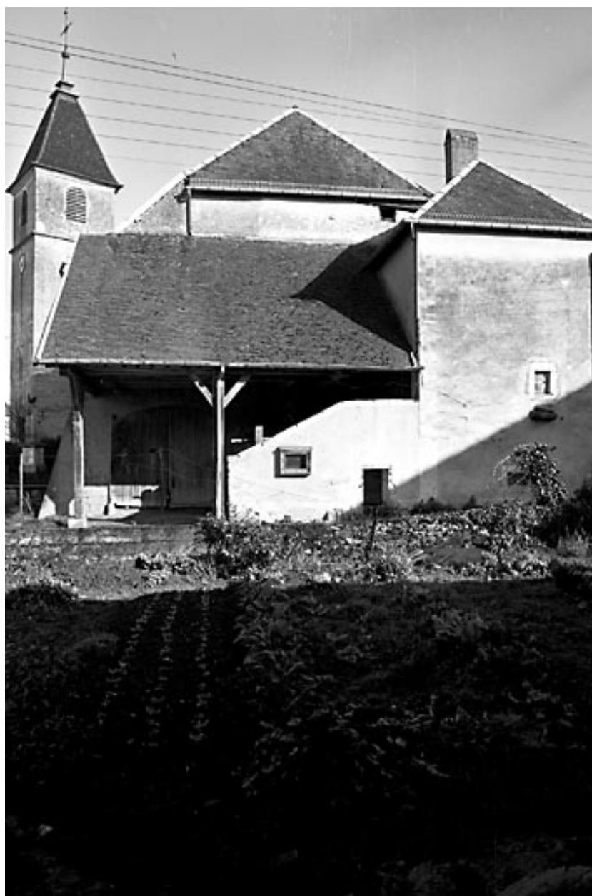
Façade latérale droite en 1984.
