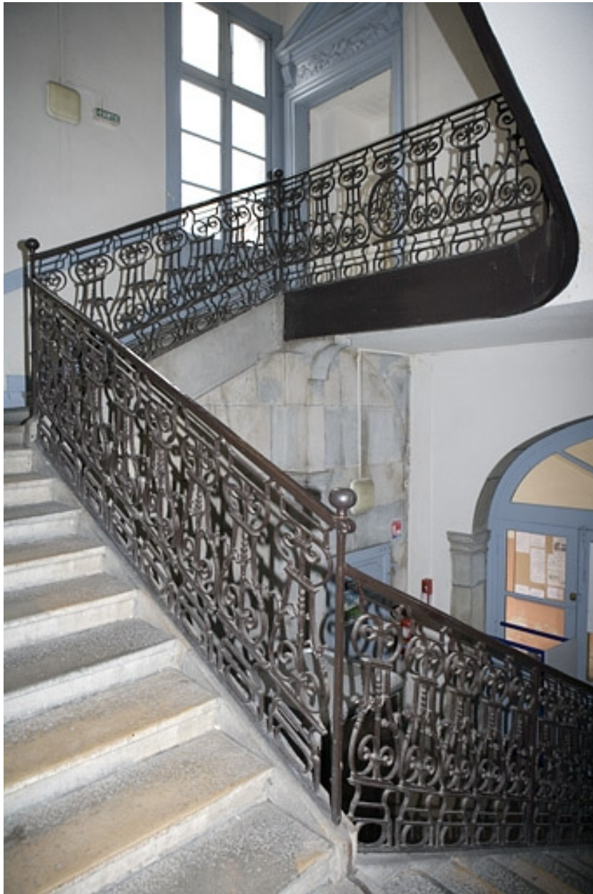
Vue d'ensemble de l'escalier.
