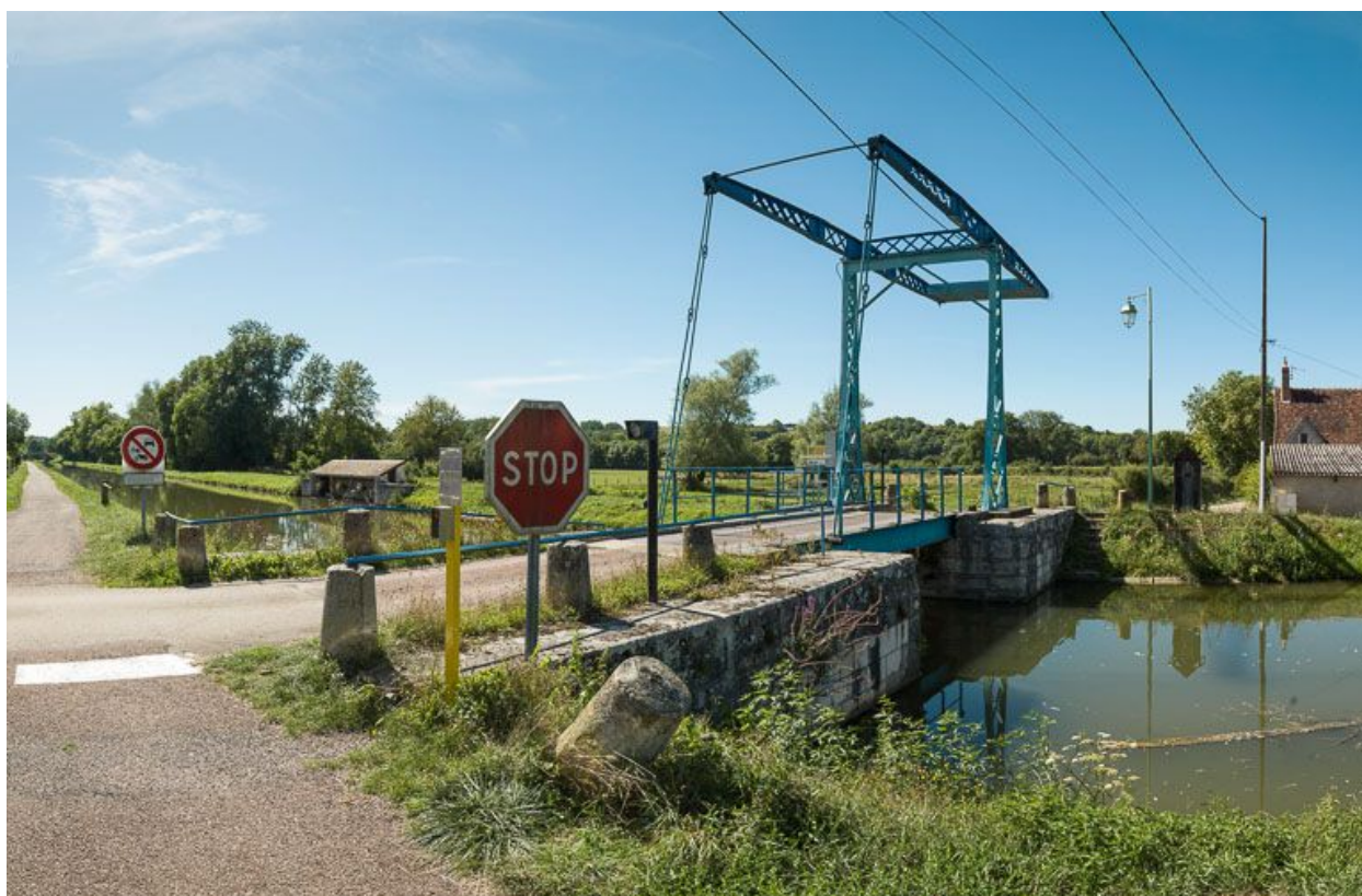
Vue d'ensemble du pont.
