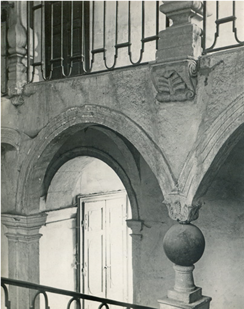
Escalier dit " aux boules de pierre ". Détail, s.d. [vers 1970].
