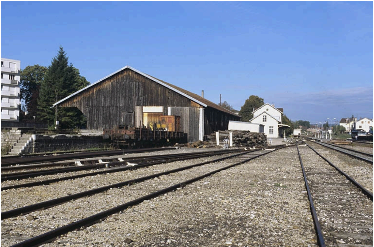
Entrepôt : vue d'ensemble, depuis le sud-est.
