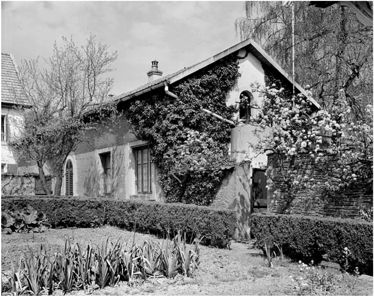
Anciennes écuries. Façades sud et ouest.
