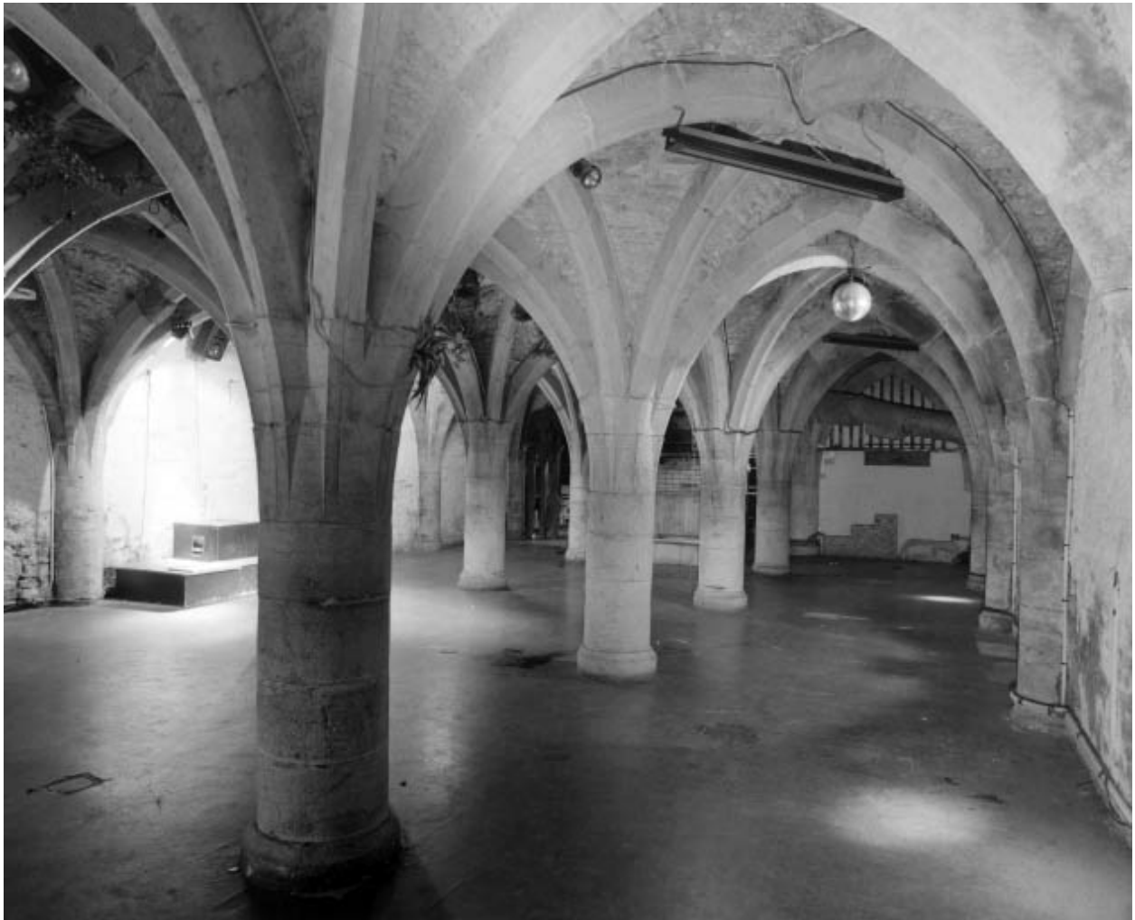
Sous-sol de l'aile droite : vue d'ensemble depuis l'entrée, partie droite.
