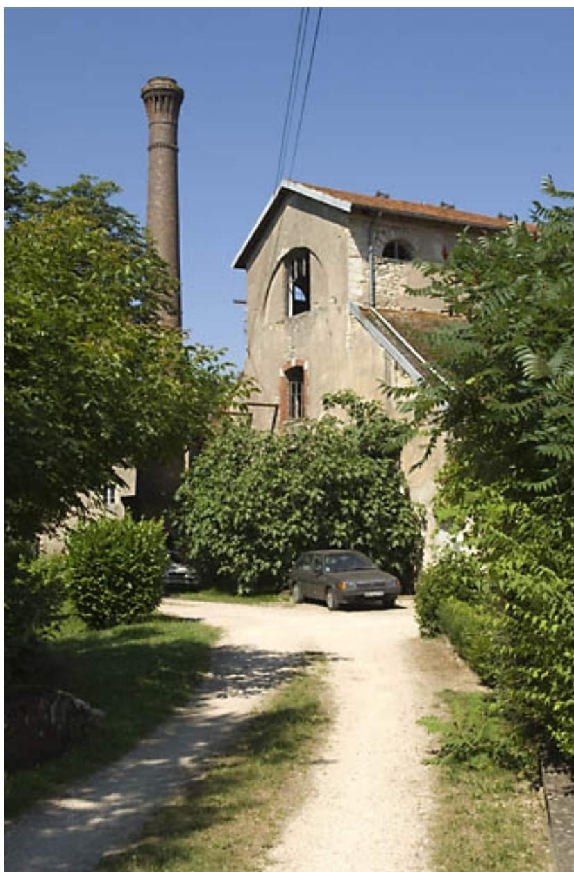
Vue du haut fourneau depuis l'entrée.
